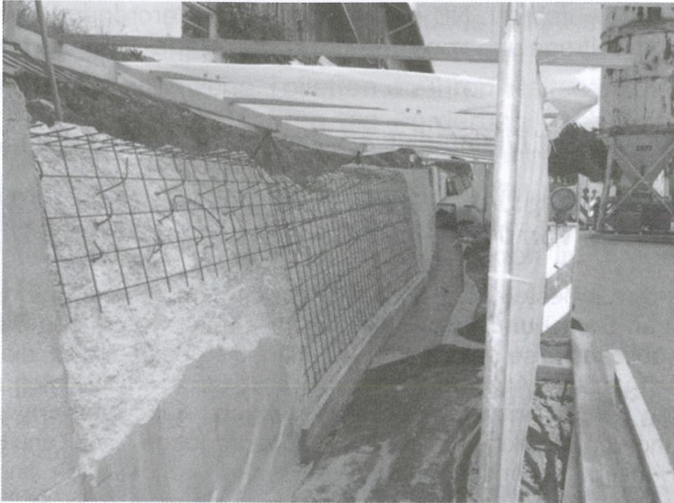
Derzeit wird die Stützmauer an der Ortsdurchfahrt von Oberndorf umfassend saniert. Dazu wurden zunächst die schadhaften Abschnitte der Mauer freigestemmt, mit Hochdruckwasserstrahl gereinigt und mit Bewehrungsstahl versehen. Außerdem wurde die Mauer mit Dübeln rückverankert. Anschließend wird die Stützmauer an den Schadstellen mit Spritzbeton wieder vervollständigt und mit einem Oberflächenschutzsystem versiegelt. Die Baukosten belaufen sich auf rund 45.000 EUR.
